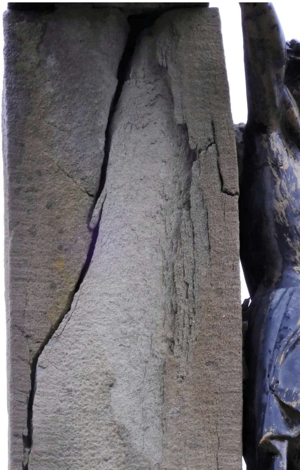
Fot. nr 4. Hażlach, cmentarz parafialny przy ul. Kościelnej, kamienny krzyż ofiar Wojny Światowej. Widok z bokłu - fragment. Stan przed konserwacją. Widoczne: zniszczenia spowodowane procesami wietrzenia (mechanicznego i chemicznego), oraz procesami deterioracji, pęknięcie krzyża pod belką poziomą.
